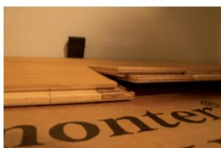
Dirigez la languette de la première lame vers le mur et commencez de gauche à droite. Il est conseillé de laisser un joint de 10 mm à 15 mm (selon la taille de la pièce) entre la lame et le mur à l'aide de cales, pour que le parquet puisse s'élargir. Posez la deuxième lame de la première rangée dans la rainure du côté frontal de la première lame. Veillez au bon alignement ! Pour fixer la
