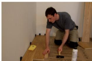
Admonter recommande le kit de pose pour rainure et languette. La rainure de la première lame est dirigée vers la cloison et doit être alignée parallèlement à la cloison. Il faut respecter la distance de la cloison avec des cales (selon la dimension de la chambre – 10 – 15 mm), pour que le parquet puisse s'étendre sur toute la surface. Appliquer la colle en la distribuant régulièrement dans les
