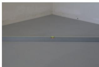
La condition pour une pose professionnelle est un support parfait (plat, sec, propre, sans fentes,) selon norme applicable (DIN18356). Pour des sols, qui ne sont pas juste selon norme DIN 18202 avec des systèmes lock-it il faut prendre en compte des exigences élevées (il faut prévoir un lissage. Il faut vérifier l'humidité maximale de l'enduit (par exemple chape
